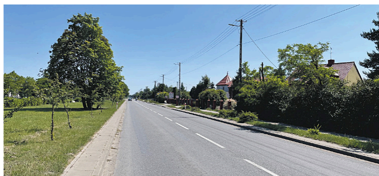
Na tym odcinku drogi wojewódzkiej nr 702 może powstać nowa infrastruktura rowerowo-piesza.
